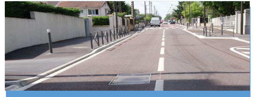
Voirie et espaces publics
