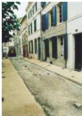
La rue de l'Huilerie et la rue des Fossés vont ressembler à leur voisine de la Porte-Saint-Jean.
