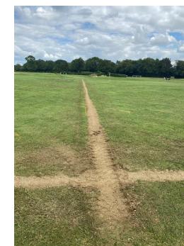
1 ère phase Drainage du Practice juillet 2023
