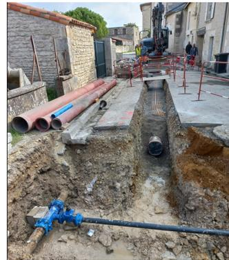
Figure 7 : réseau EP et AEP Frontenay RR
